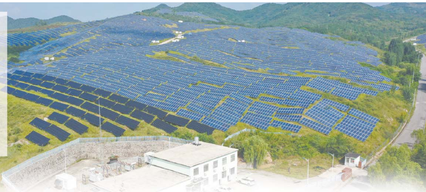
位于济南市莱芜区口镇的独立储能电站和周边的光伏发电项目。(本报通讯员 王宪才 摄)
