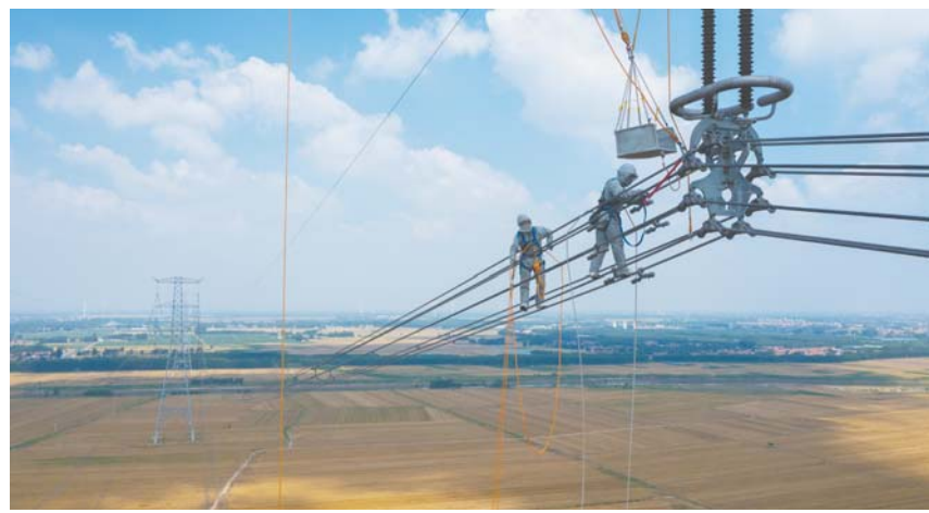
国网山东超高压公司组织工作人员对特高压输电线路进行检修。(本报通讯员 隗茂春 摄)
