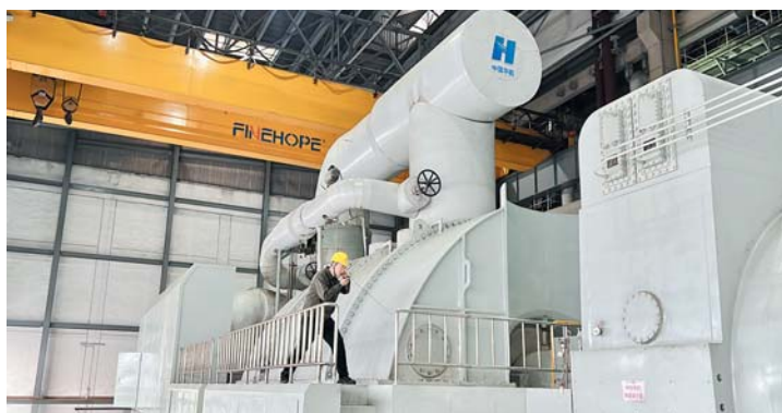
运行人员巡检汽轮机。
