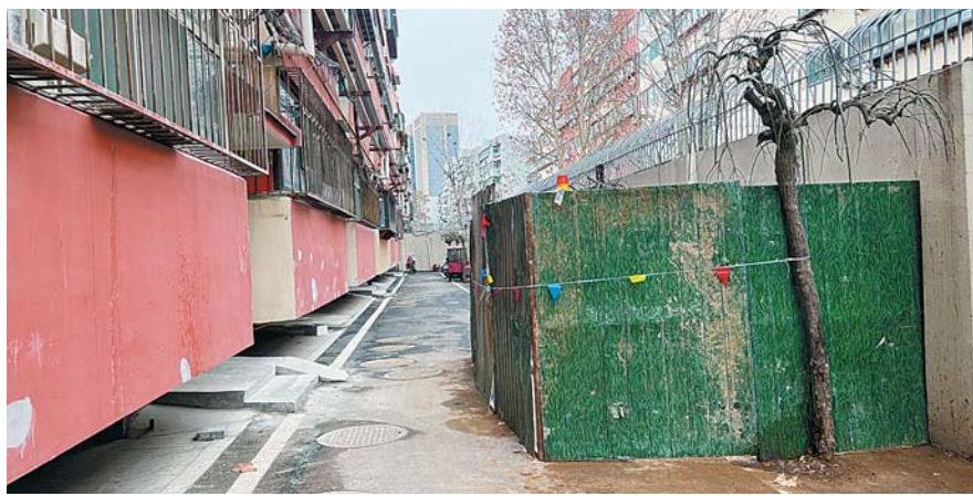
济南市纬五路一小区1号楼3单元加装电梯阻碍了道路。
