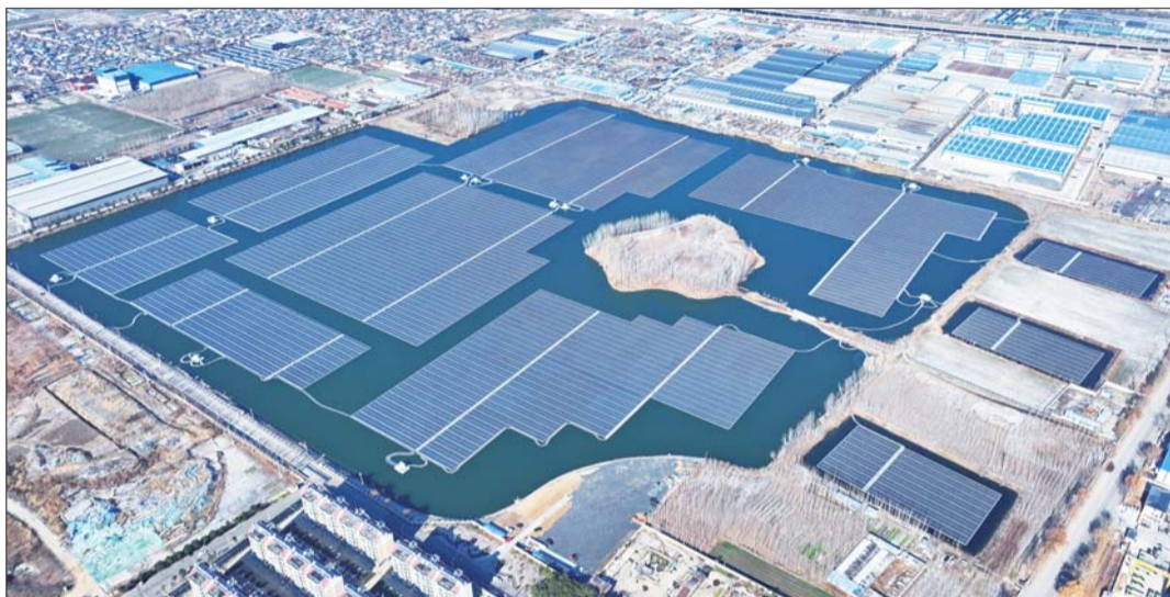
宁德时代国家大型光伏基地项目并网发电。
