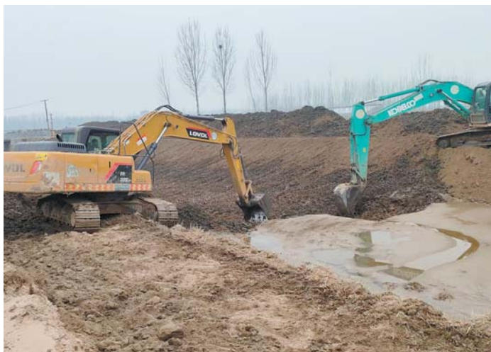
为确保返青水浇灌安全顺利进行，仁风镇及早对辖区沟渠进行清淤。
