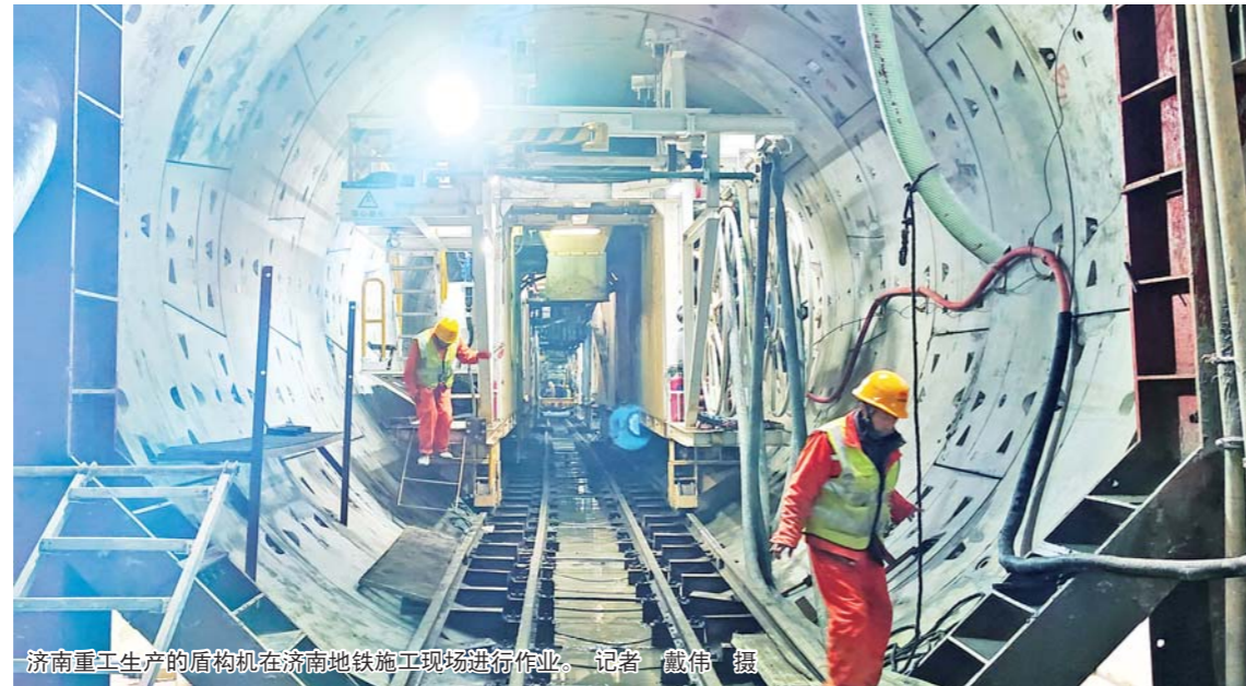
济南重工生产的盾构机在济南地铁施工现场进行作业。记者 戴伟摄
