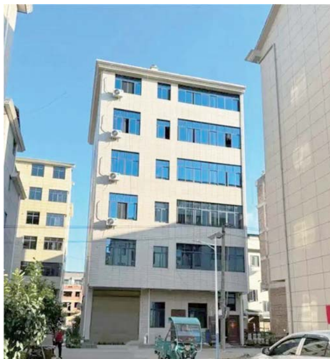
“提灯定损”事件中的自建楼，陈某房间在6楼。 视频截图
