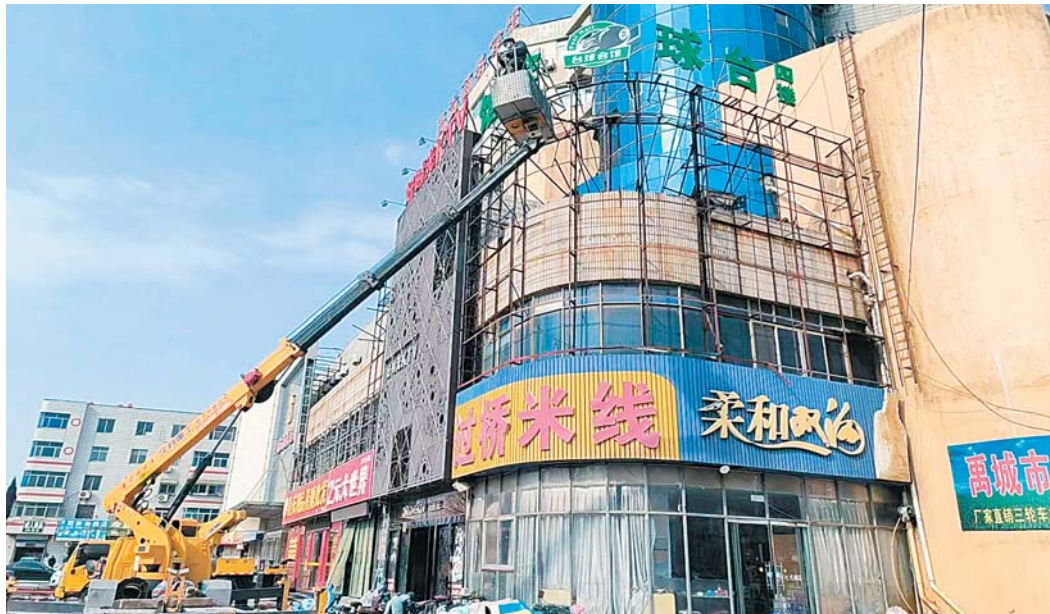
德州禹城,工作人员正在借助工程高举车拆除开元商厦附近的广告牌。 山东消防供图
