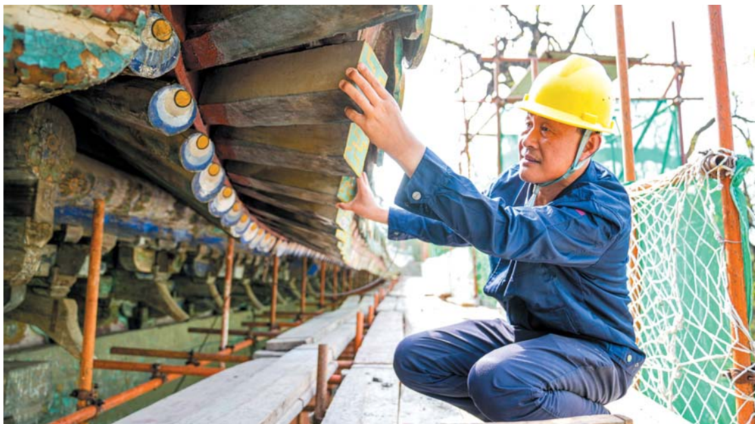
孔令伟对圣迹殿大架木构件进行检测。
