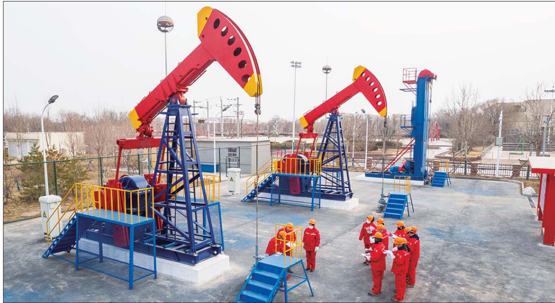
孤东采油厂组织高校毕业生现场培训。
