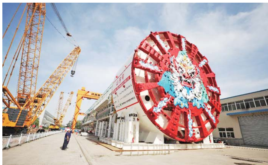
5月19日，世界在建最大直径泥水盾构机“山河号”在济南下线。
