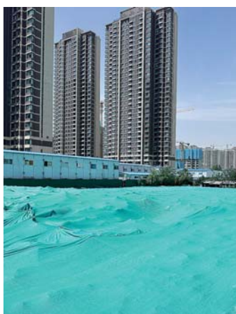
项目规划用地地面被绿色土工布覆盖。
