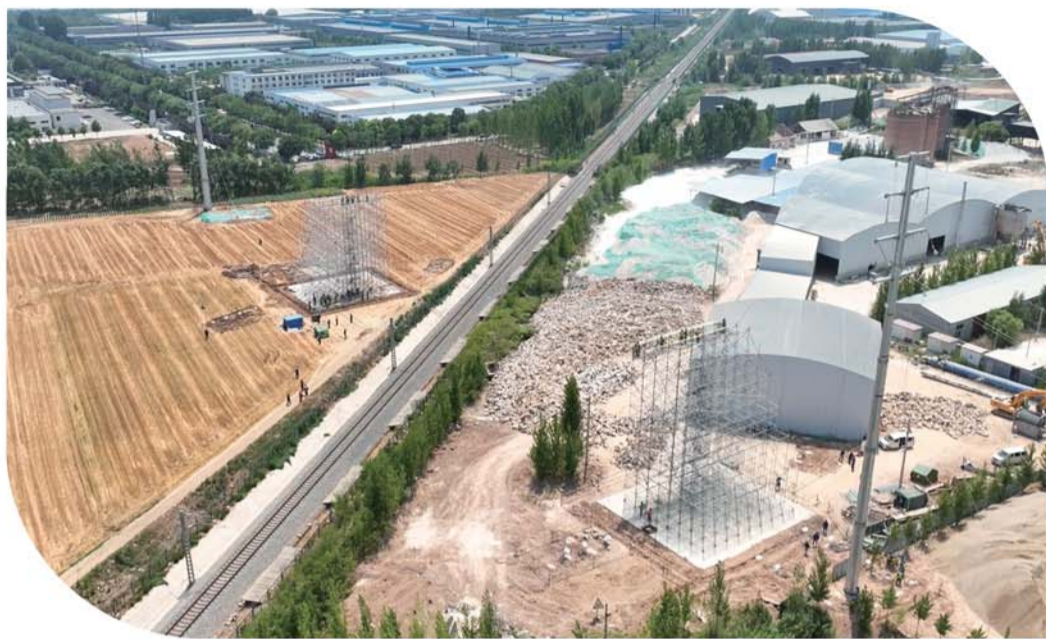
加快迎峰度夏电网工程建设进度。
