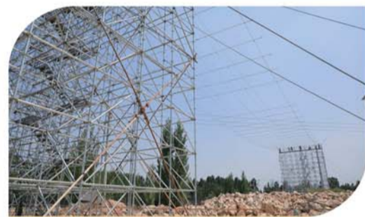
安全网顺利铺设到位。
