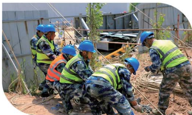
一根根牵引绳被固定在地锚上。
