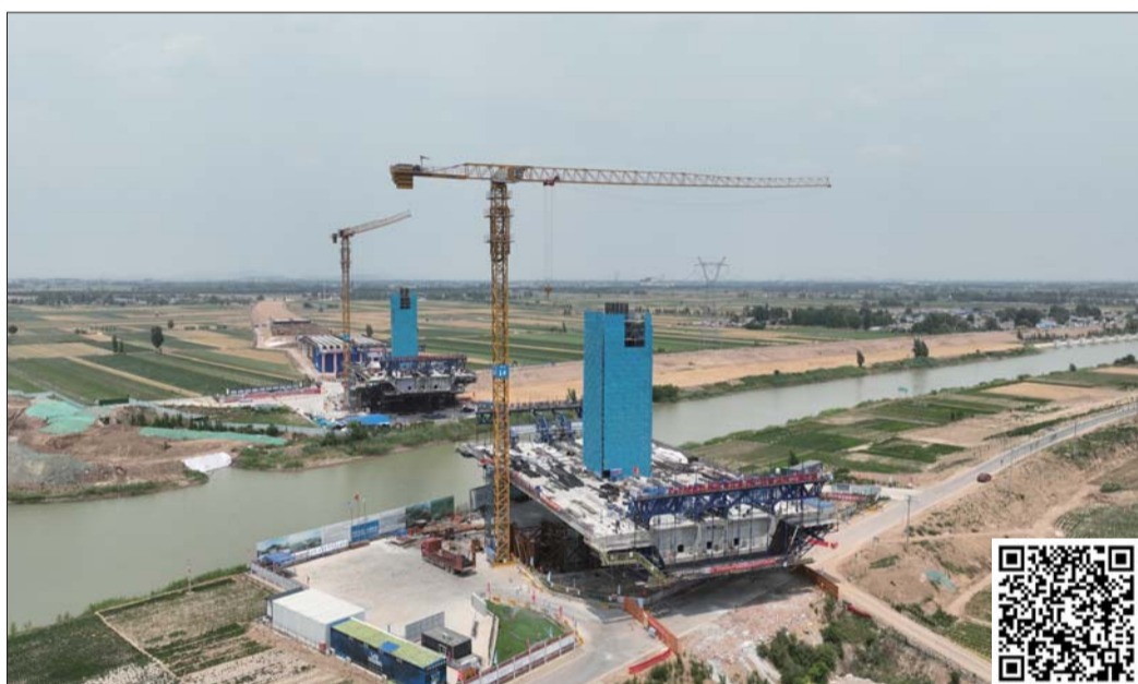
济商高速项目施工现场。
