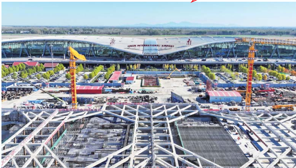
济南遥墙机场二期改扩建现场。
