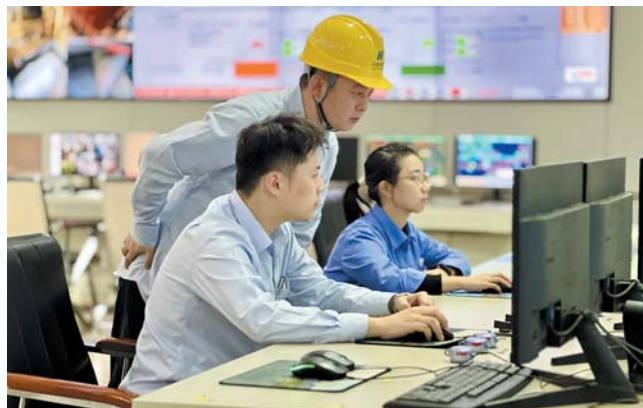
黄台电厂运行人员严格监盘。
