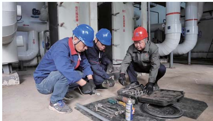
工作人员在进行换热站除污器拆卸前的准备工作。
