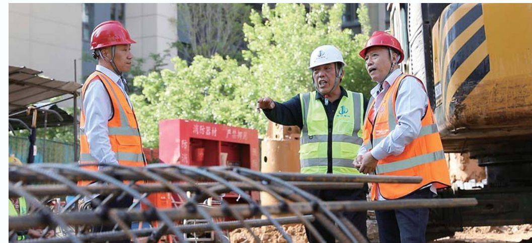
奥体东片区隔压站建设项目正在如火如荼地进行。
