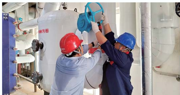
换热站检修现场，工作人员正在进行检修工作。
