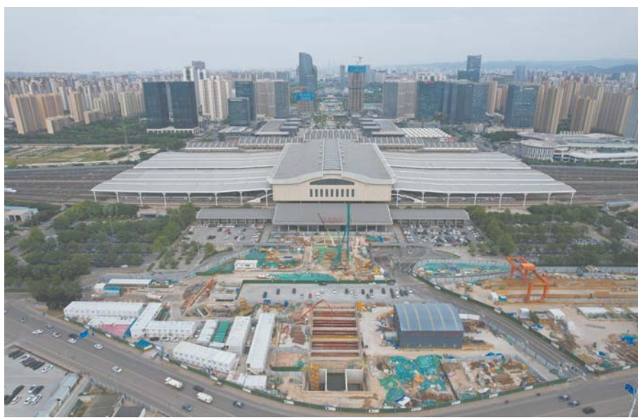
济南地铁4号线济南西站施工现场。
