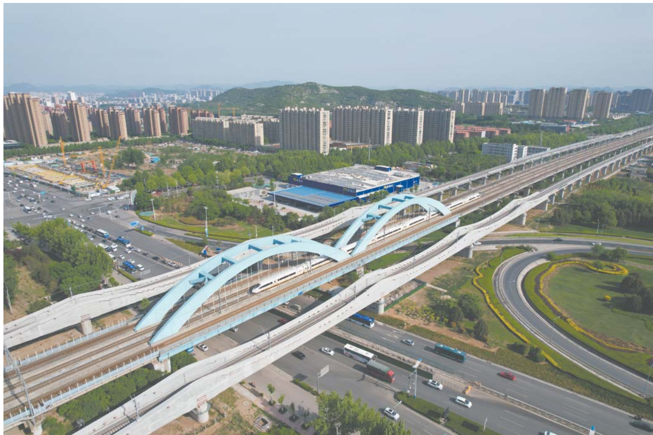
济南地铁4号线“济大”盾构区间连续下穿3条高铁线。
