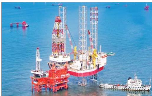
近日,新胜利五号钻井平台使用旋转导向+LWD(随钻测井)工艺对埕北4EB-侧平10井进行侧钻施工,不仅缩短钻井周期,且能实现精准着陆直达油层。
