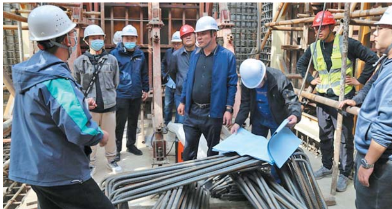
组织人防工程施工材料质量检测。
