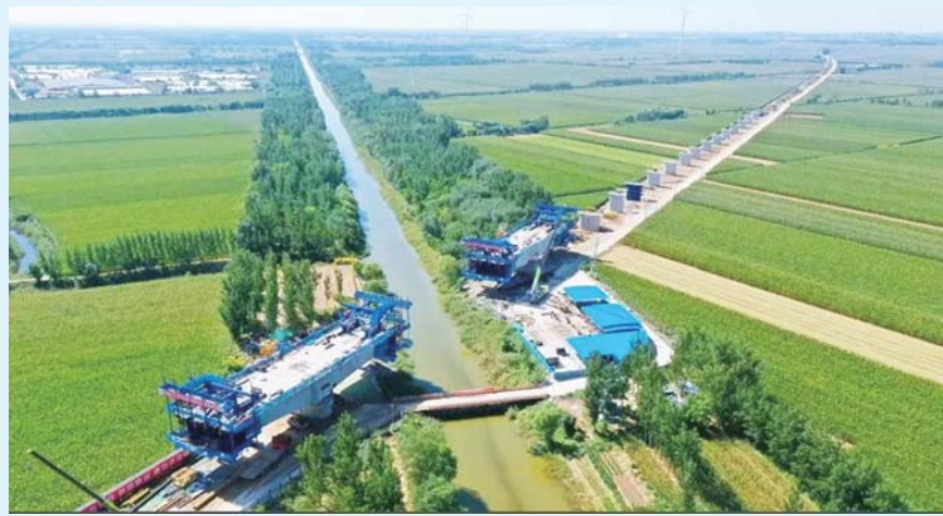
在济滨高铁项目商河段建设现场看到,商河段下部结构施工基本完成,工人们正在紧锣密鼓地推进架梁等施工。
