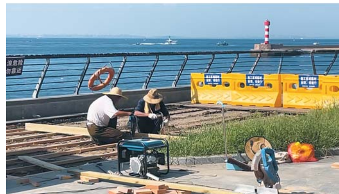
现场有工人正在进行维修。
