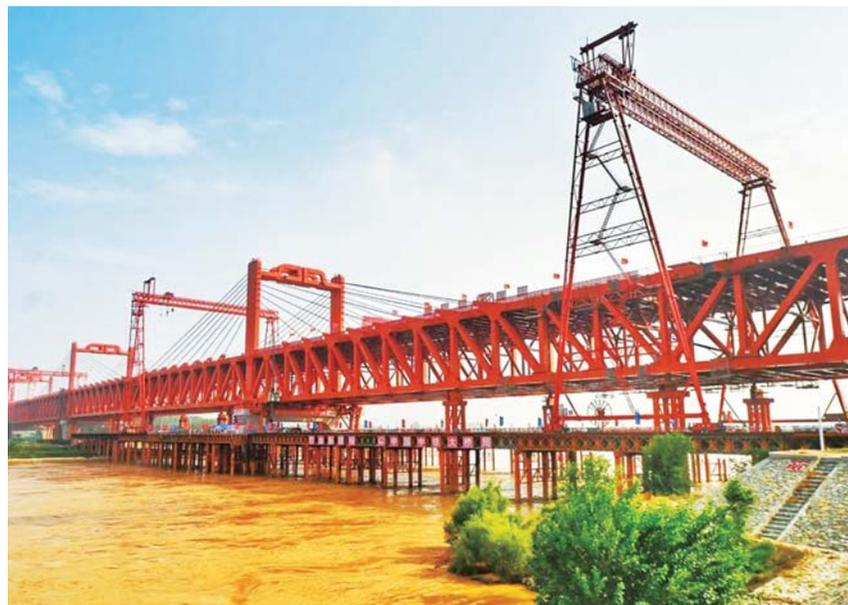
项目采用分节段整体吊装施工工艺，攻克航空限高区大节段钢塔安装难点；创新双悬臂架设施施工工艺，采用压重精准配平方案，攻克多主跨、不对称、超宽双主桁钢桁梁拼装及安装难点；采用双悬臂、非对称合龙结构，攻克多跨不对称钢桁梁合龙难点；采用大直径索股和特殊张拉工艺及专用大吨位张拉千斤顶，攻克矮塔小倾角超大吨位间斜拉索安装难点，创造了钢梁架设441天无事故及精准合龙新纪录。开工721天、首架441天，用时不到两年就完成了全桥合龙贯通，施工较指导性施组提前5
