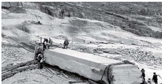
工人们在山坡上铺设枕木滑轨,用钢缆捆住石料,将花岗岩由山上缓缓放至山下。
