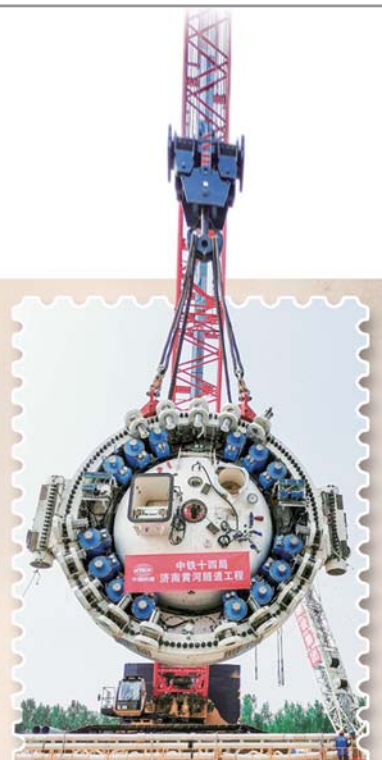
2019年6月17日，济南黄河隧道工程第一台盾构机主驱动吊装下井。
