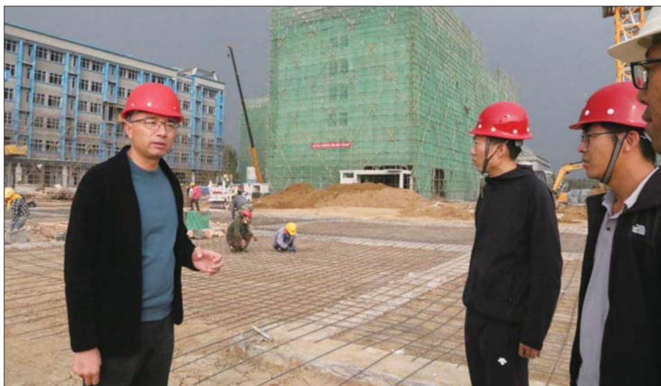
王田假期坚守项目一线。
