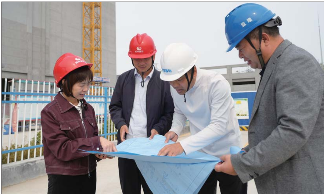
基建专班成员坚守项目一线。
