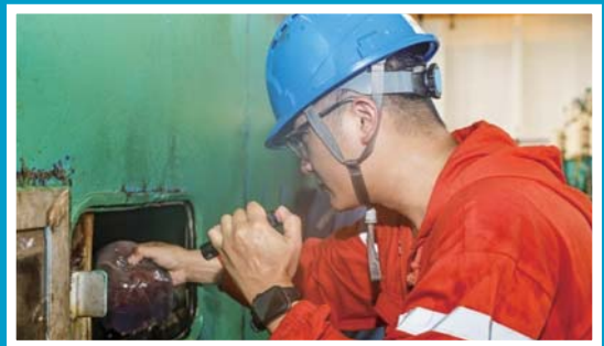
▲入侵电厂的海蜇数量惊人。 ▶发电厂员工从过滤海水的旋转滤网上摘下海蜇。
