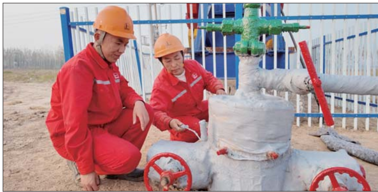
注采507站员工在商25-6井对井口进行冬防保温。 通讯员 张滕 摄
