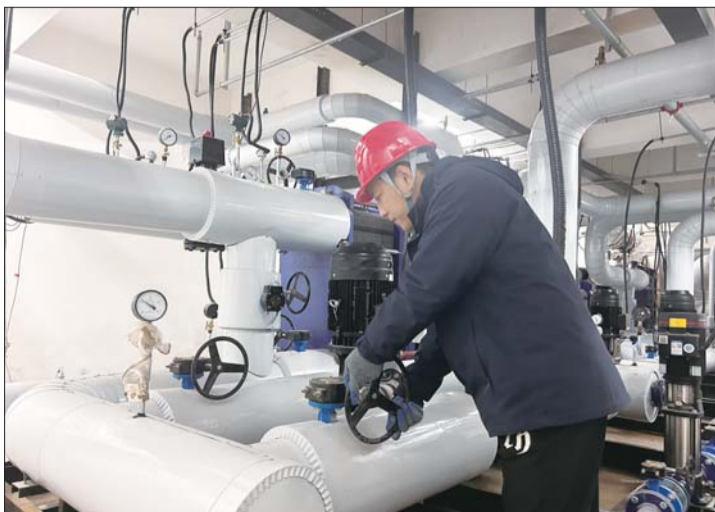
聚源热力公司正在对供热设施进行检修。
