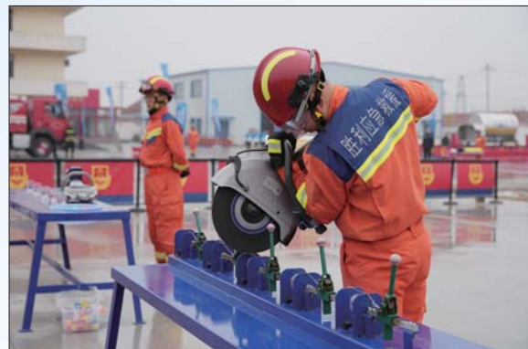
应急战斗员使用无齿锯，实施精准切割。
