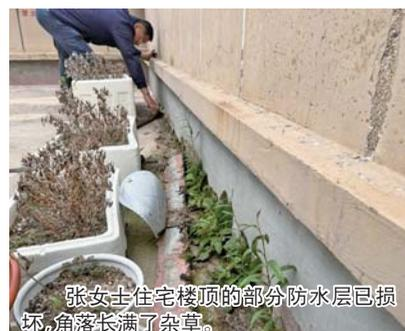
张女士住宅楼顶的部分防水层已损坏，角落长满了杂草。
