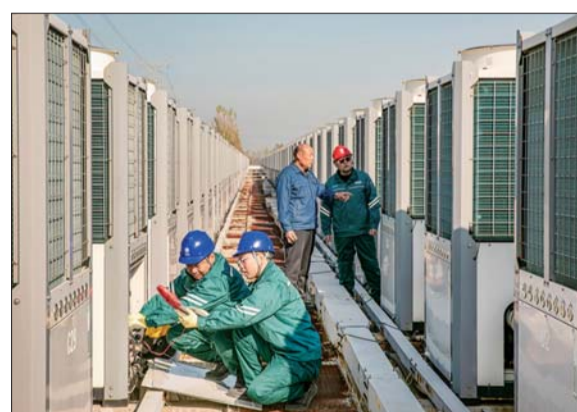
排查“煤改电”供暖小区电力设备隐患。
