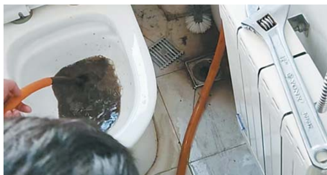
维修人员上门为居民家中暖气片放水,解决供热问题。
