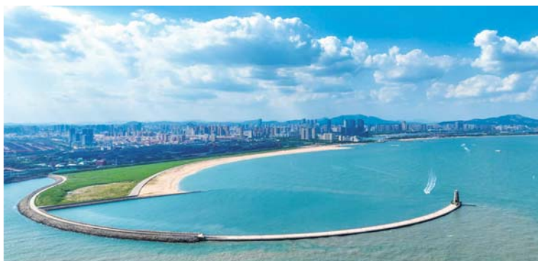
▲全国首个退港还城修复整治工程海龙湾。
