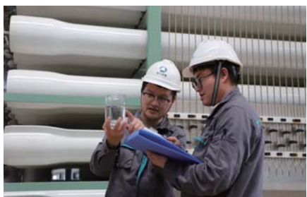
两名环保技术人员在中水回用设备前观察处理后的水样。
