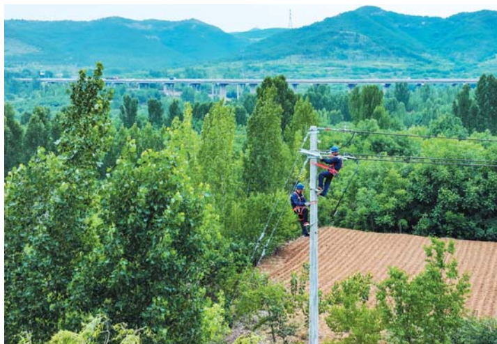
国网山东济南供电公司员工正在开展10千伏虎门线架线施工作业。冯立文 摄
