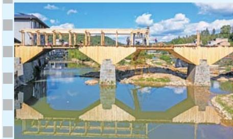
在福建省屏南县长桥镇,工匠在修复万安桥时架设廊屋梁柱。 图片均为新华社发
