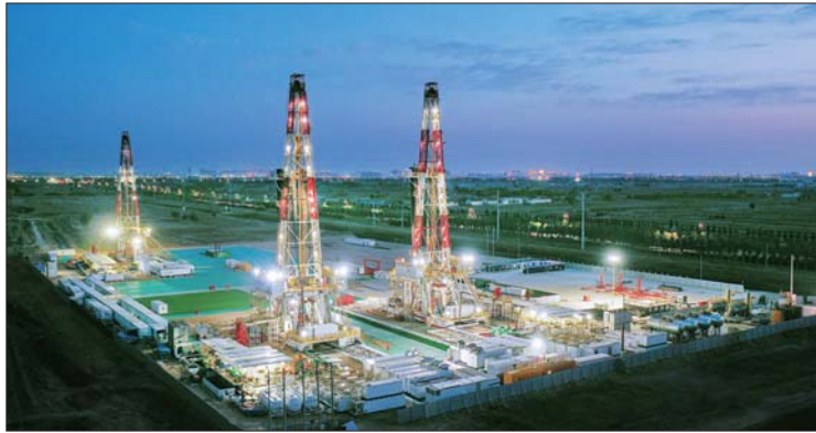
在民丰区块丰页2号台,3台钻机正在有序施工。
