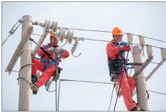
渤海供电管理区集中力量为新井安装避雷器。 通讯员 孙绍华 摄
