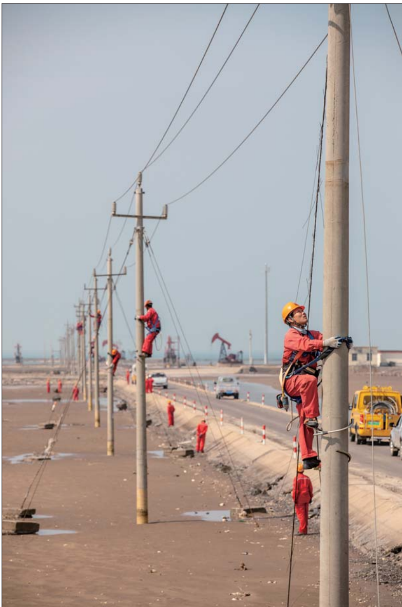
孤东供电管理区员工攀上高压塔顶，在35千伏东二五线进行线路检修。通讯员 王国章 摄
