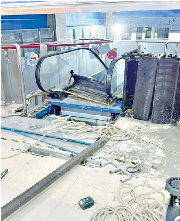
电动扶梯被拆除。
