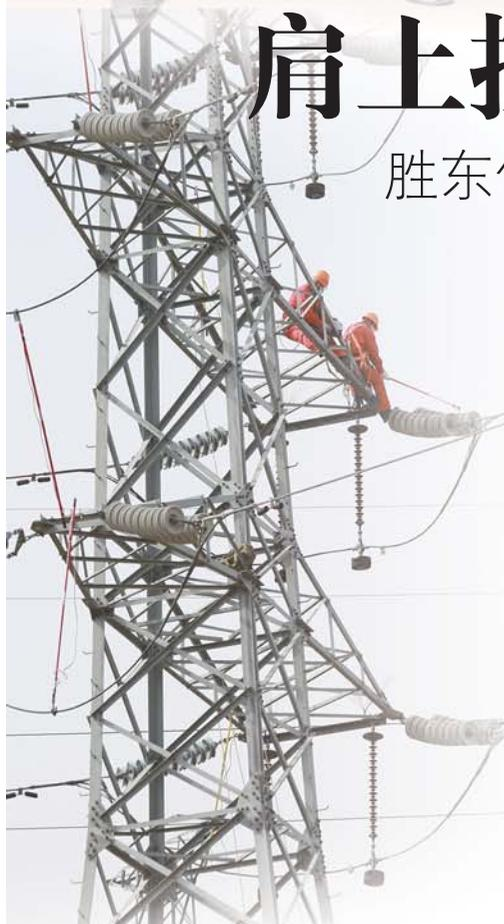
输电运维工作站职工在220千伏电力线路,对绝缘子进行绝缘测试。通讯员 张振轩 摄
