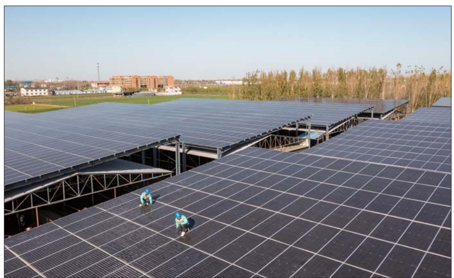
国网嘉祥县供电公司全力确保项目顺利推进。
