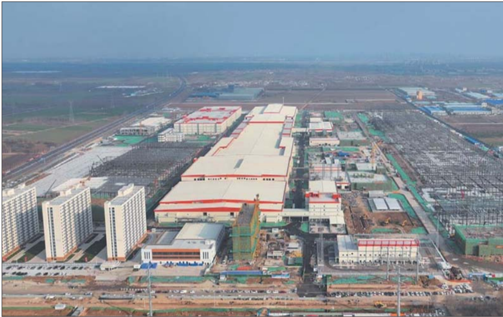
位于济宁兖州区的山东时代新能源电池基地项目一期厂房主体建设已完工，配套设备正进场安装。
