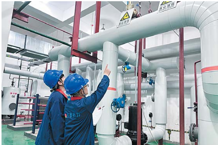
加强巡检，保障供热管网的运行安全。
