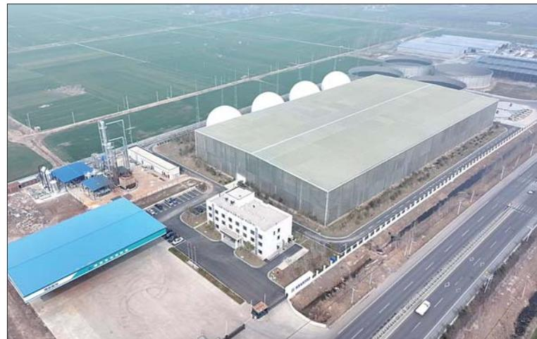
生产生物质天然气和有机肥,可实现年收集、处理畜禽养殖废弃物及农作物秸秆36万吨,年产天然气2580万立方,年产有机肥30000吨。
