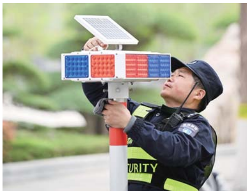
刘新锋调试校园里路口信号灯的太阳能板。
