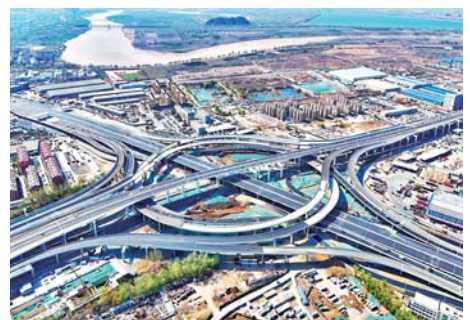
济南零点立交工程建设进入最后冲刺阶段。
