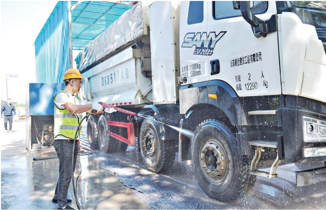
渣土车冲洗到位，拒绝“带泥上路”。
