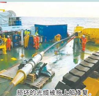
损坏的光缆被拖上船修复。
