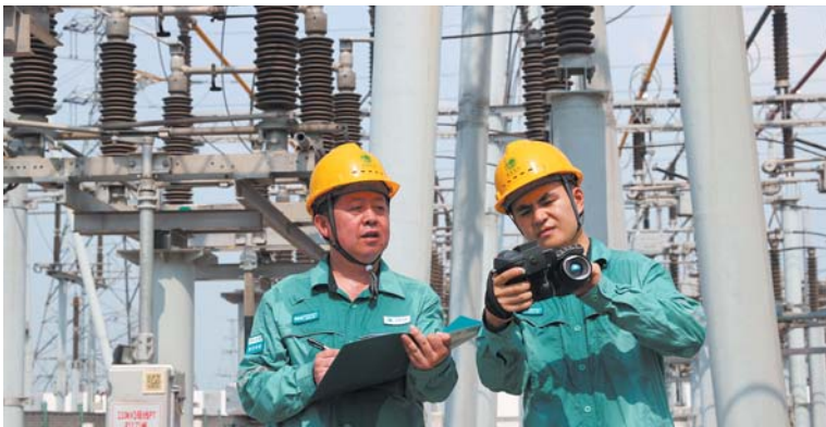
国网济南市济阳区供电公司员工在高温高负荷时段巡视测温变电站设备。
